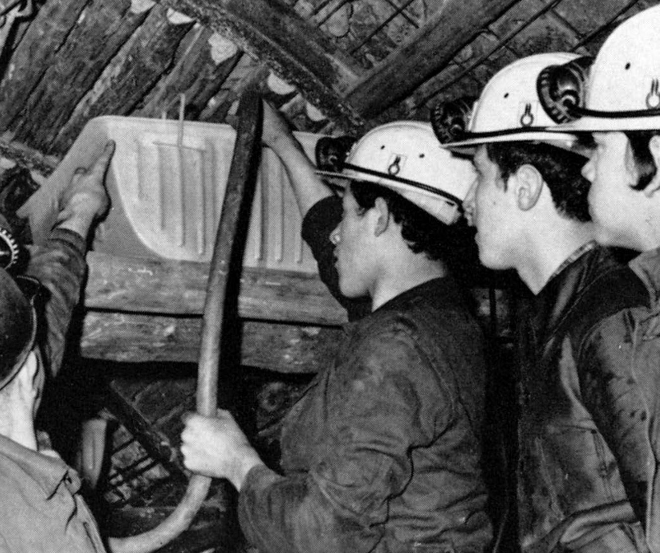
▲ 1970 Die Ausbildung zum Knappen sieht auch Unterweisungen in grubensicherheit- lichen Arbeiten vor, hier Füllen von Wasser- trogsperren im Lehr- stollen Camphausen
