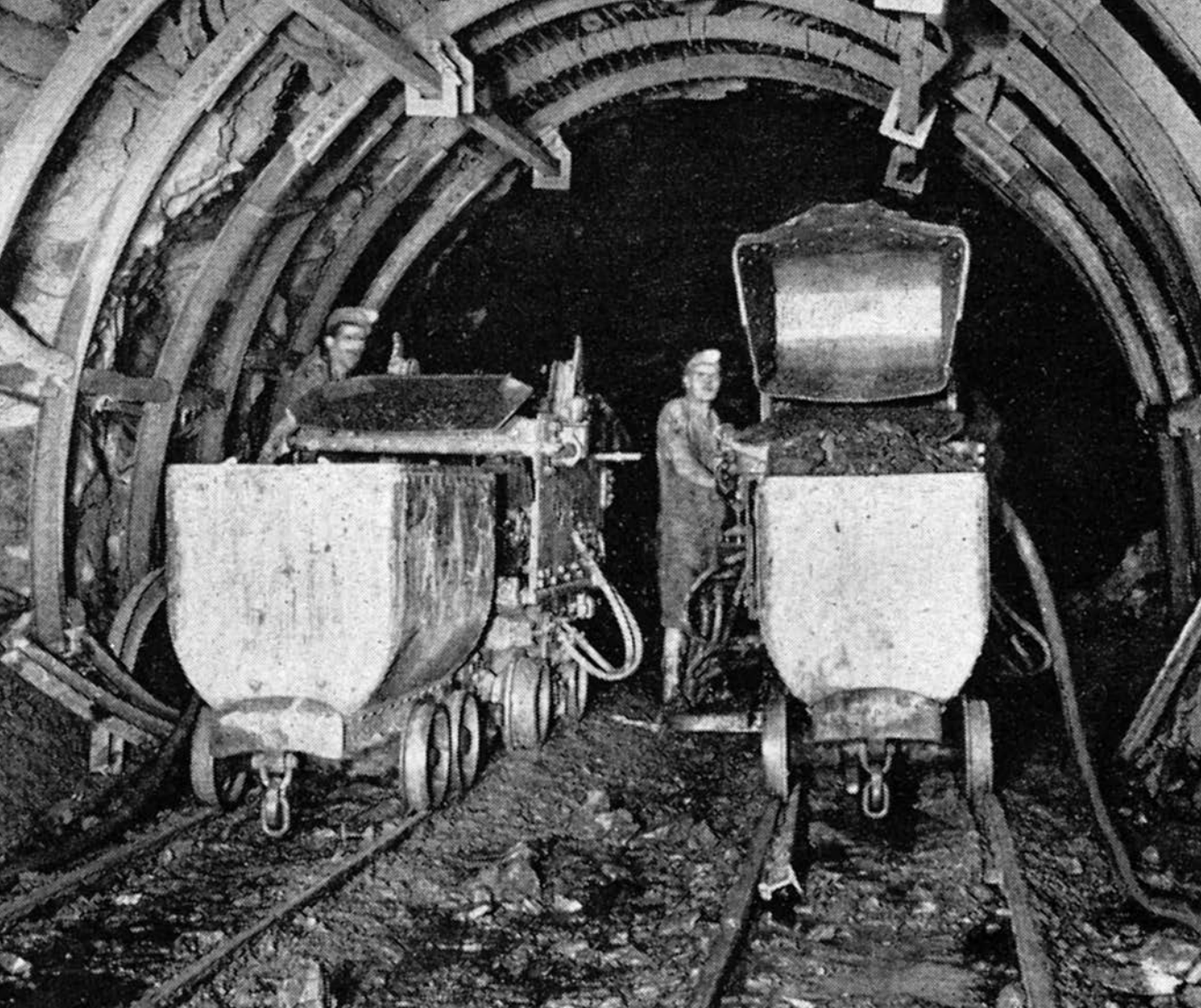
1959 Gesteinsstrecken- vortrieb mit Förderwagen
