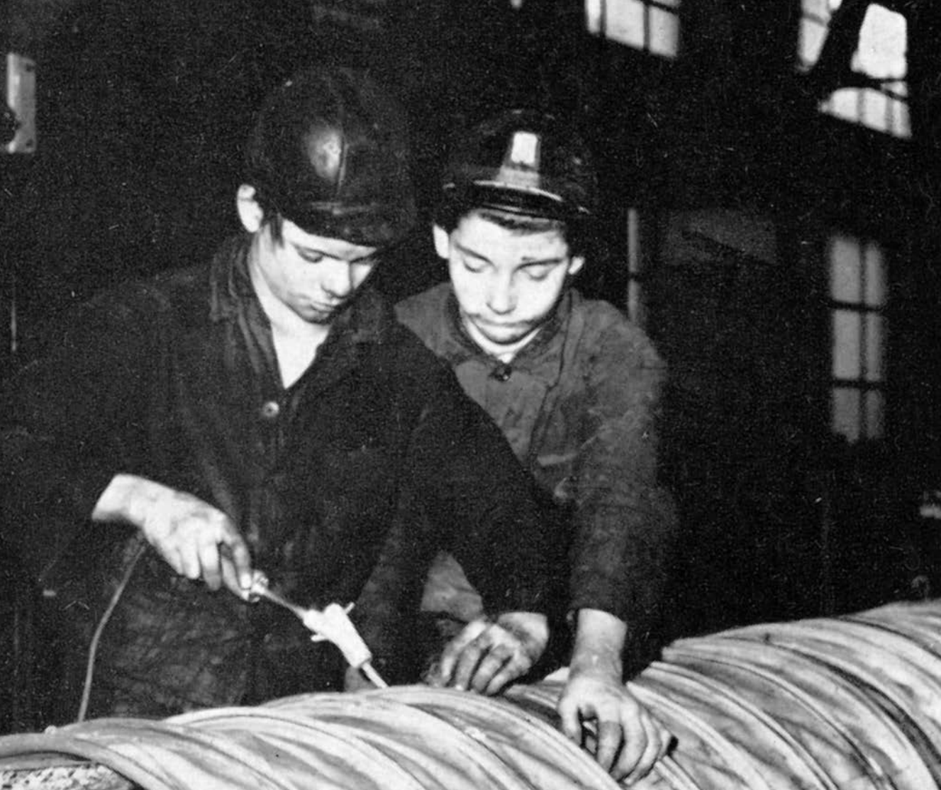
1961 Berglehrlinge in der Lehrstätte Camphausen bei der Reparatur einer Kunststoff-Lutte
